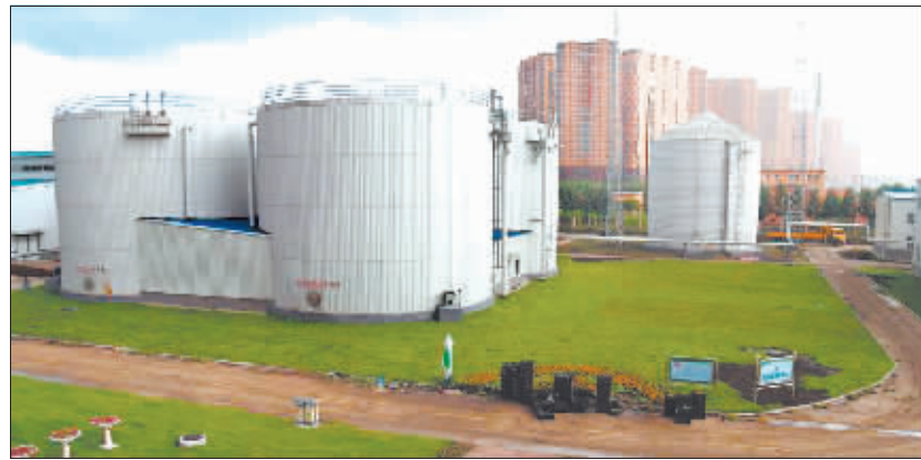
处理餐厨废弃物的厌氧发酵罐。
