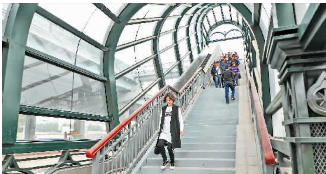
昨天,海城桥的桥体加宽工程路面铺设完毕。公交6路、16路、108路及113路公交车站台已调整至该路段。今后,旅客可在此乘坐桥体两侧的电动扶梯或步行梯,顺利前往哈尔滨火车站北广场。
