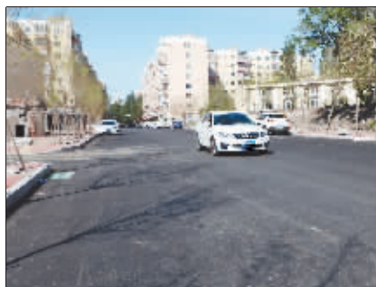
近日,道里区河江街配合地铁3号线施工打通市政道路工程建成通车。车辆可走河江街往来于阳明街和安红街之间,打通爱建地区周边道路微循环。
