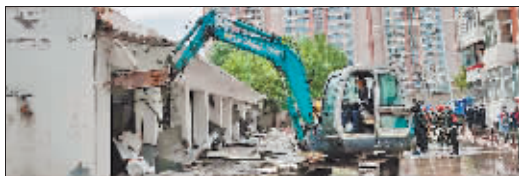
违建车库拆除现场。
