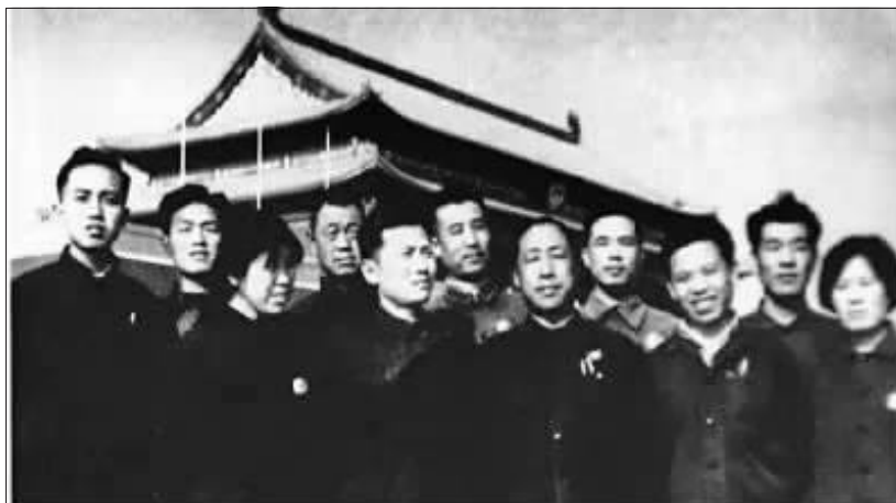
天安门城楼重建竣工后,部分设计人员与施工师傅留影。
