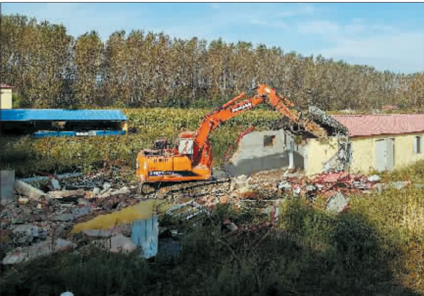
违建拆除现场。
